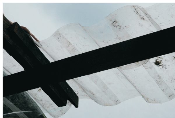
Os bolsistas da Capim Limão estão integrados com as prioridades da extensão rural. As telhas transparentes trazem maior luminosidade para os galinheiros.
